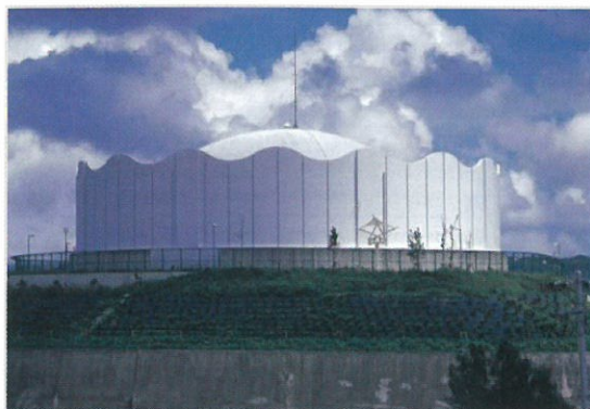
安里配水池（沖縄県）
