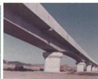
山陽新幹線：芦田川橋梁
