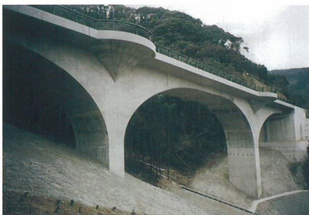
城山台稻佐町線橋梁（長崎県）
