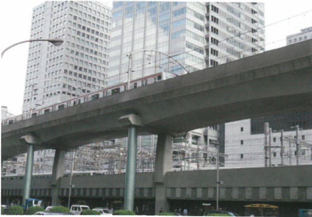
中央線東京駅付近 PC 桁（東京都）
