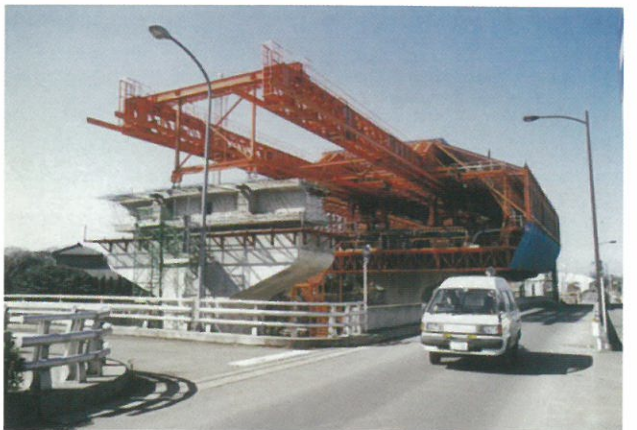
大型移動支保工により施工された東京外環道安行西高架橋（埼玉県）
