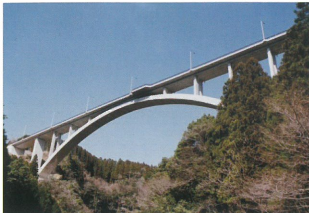
国内最大規模のロアリング工法により施工された 神原溪谷大橋（大分県）
