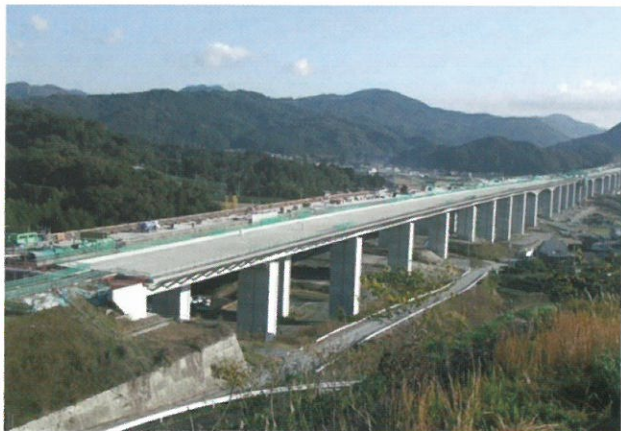
延長約 1.4km の第二東名宮ヶ島高架橋 (静岡県)
