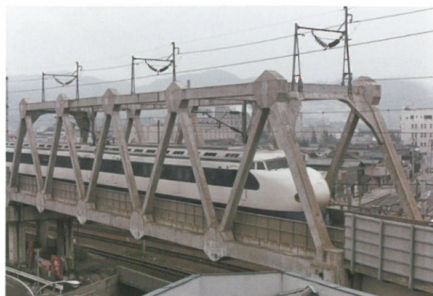
山陽新幹線引き込み線 岩鼻架道橋(広島県)
