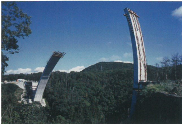
ロアリング中の三貫目大橋（新潟県）
