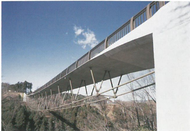
外ケーブル併用吊床版橋 いわき公園森のわくわく橋（福島県）
