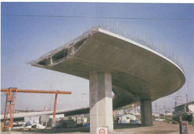
野田川右岸取付橋（兵庫県）
