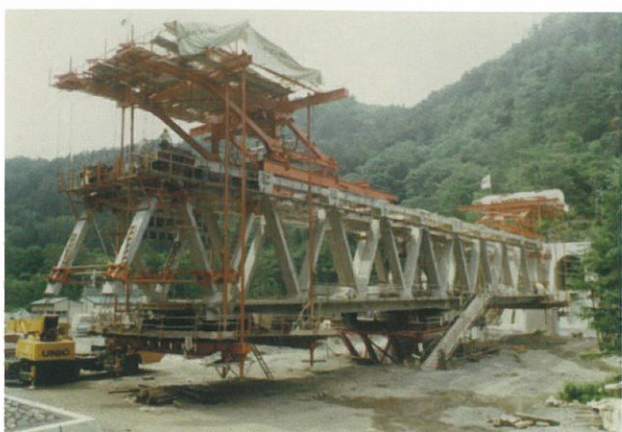
張出工法で施工した三陸鉄道楳木沢橋梁 (岩手県)
