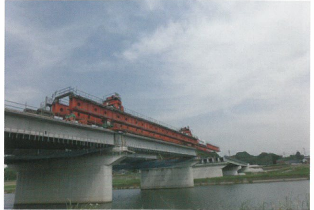
川島大橋（福岡県）
