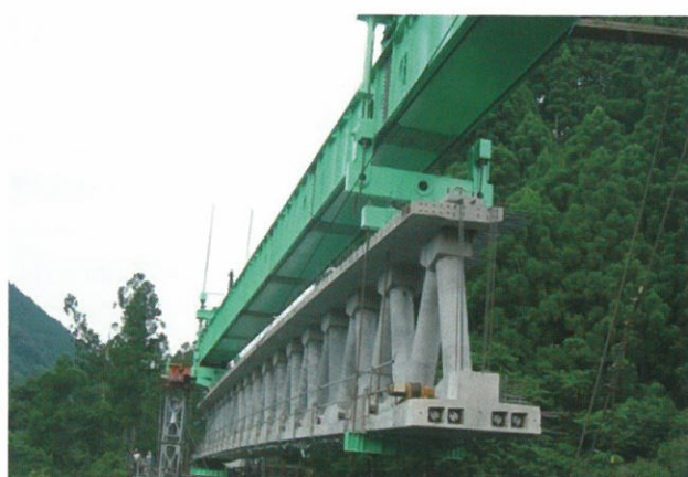
我が国初の道路橋に適用したコンクリートトラス 鎌谷橋 (徳島県)
