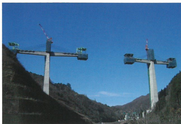
徳山ダム八徳橋（岐阜県）
