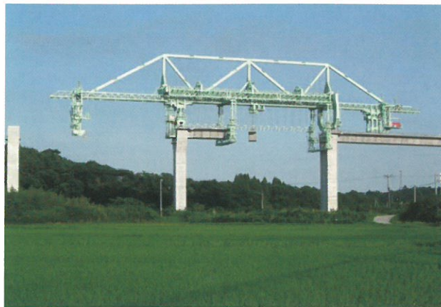
プレキャストセグメント工法により施工された 常磐自動車道木戸川橋 (福島県)
