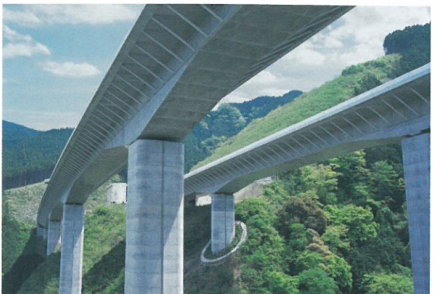
第二東名高速道路で最も高い橋脚に支えられた 芝川高架橋（静岡県）
