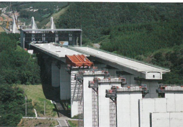
押出し工法により施工された大平高架橋（静岡県）
