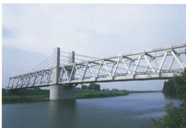
斜張形式の複合トラス橋 会下橋 (徳島県)
