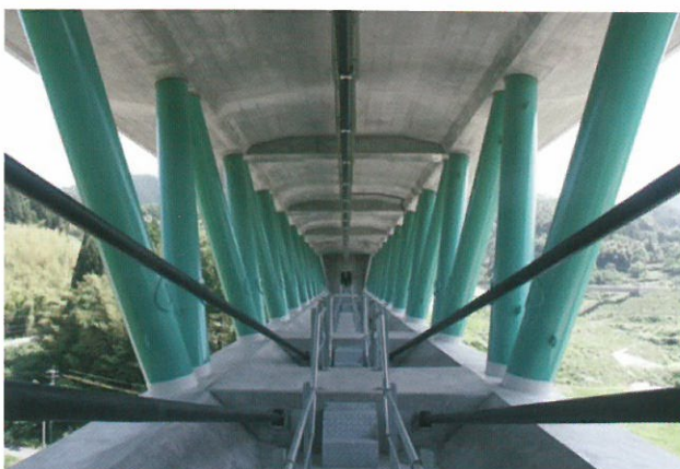
志津見ダム志津見大橋 (岩手県)
