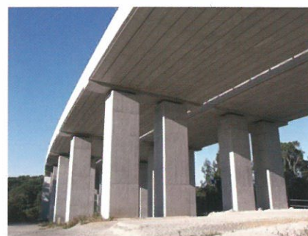
沖縄県 億首川橋 RC中空床版橋リニューアル工事
