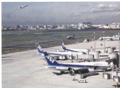
空港エプロン舗装
