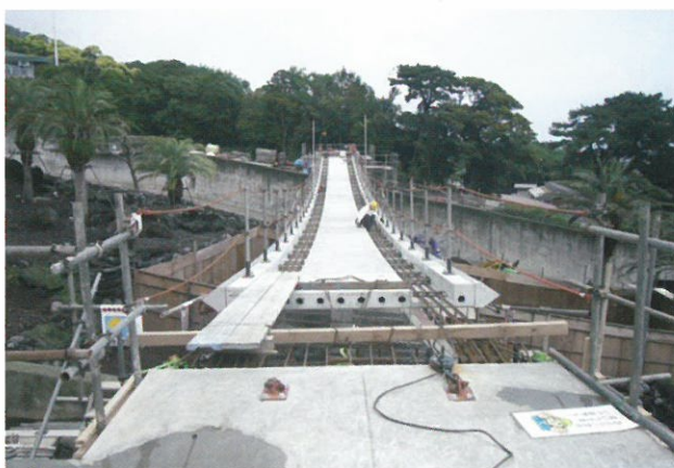
吊床版橋 大島公園サル島展望橋（東京都伊豆大島）
