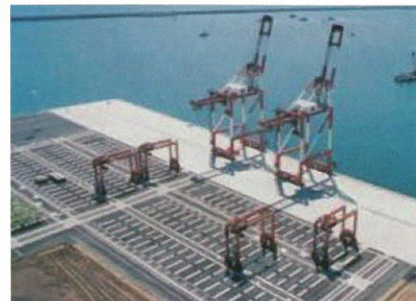
コンテナヤード舗装
