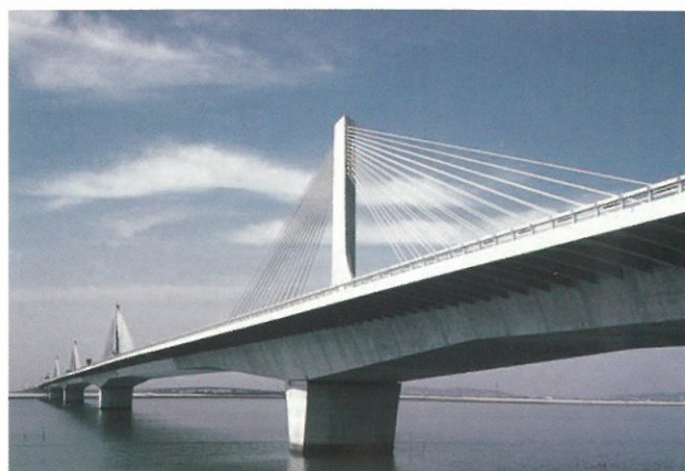
中央径間は鋼構造でコンクリート構造部はプレキャスト製 第二名神 木曽川橋（三重県）
