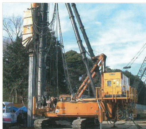
PC 壁体沈設状況
