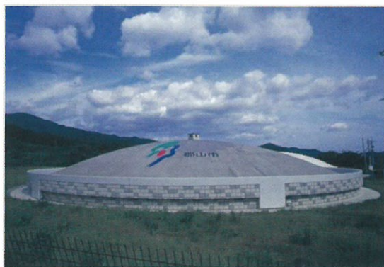
河内配水池（福島県）
