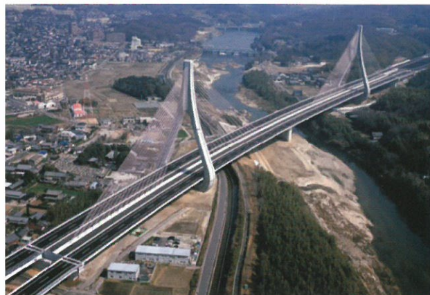
第二東名 矢作川橋（愛知県）
