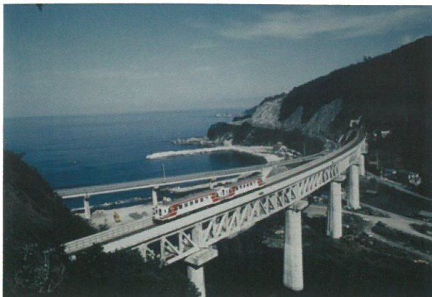
安家川橋梁(岩手県)
