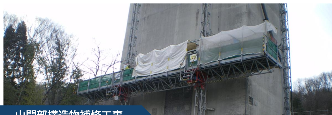
山間部構造物補修工事
