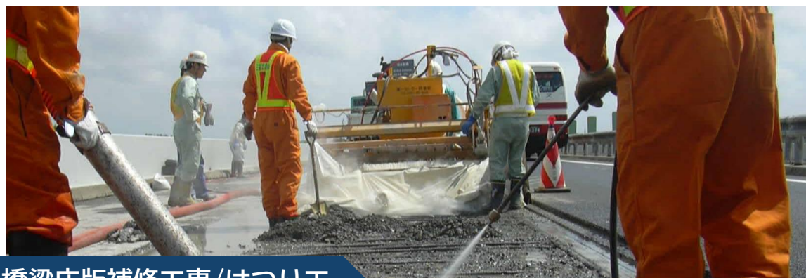
橋梁床版補修工事/はつり工
