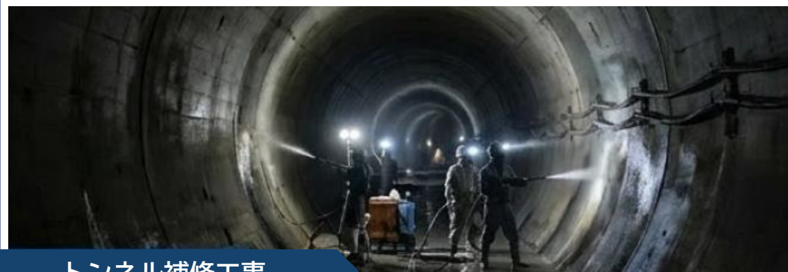
トンネル補修工事
