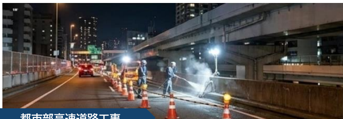
都市部高速道路工事
