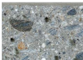
従来の床仕上げ (土間金コテ押さえ)
