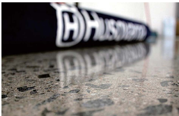
粗骨材を露出させる研磨
