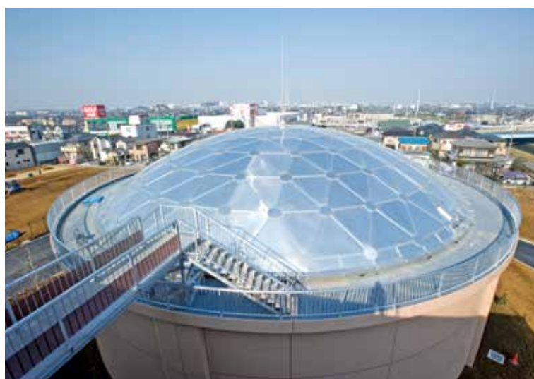
● 松伏北部配水場 埼玉県
